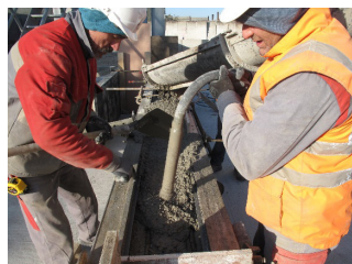
Coulage du béton recyclé
