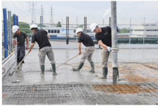
Bétonnage de la dalle terrasse
