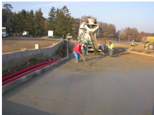
Coulage du béton recyclé
