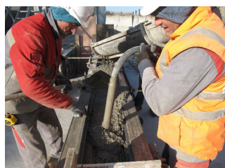
Coulage du béton recyclé
